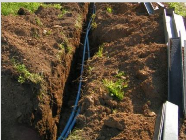
výkop pro pokládku
